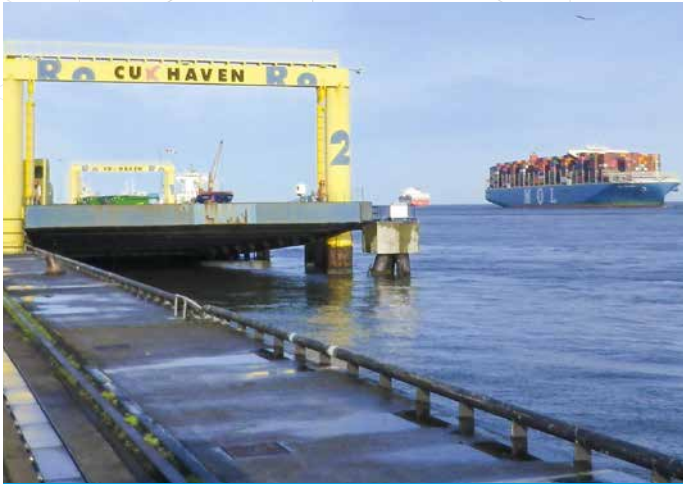
Die Kaianlage Europakai im Amerikahafen in Cuxhaven
