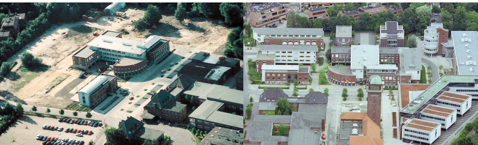
Gerade einmal gut 15 Jahre liegen zwischen diesen beiden Bildern! In großen Schritten vollzog sich der Wandel von einer ehemaligen Fleischwarenfabrik zu einem IT-Quartier.
